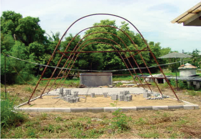
รูปที่ 5 โครงเครื่องอบแห้งที่ปูพื้นด้วยอิฐตัวนอน
