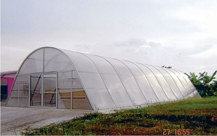
รูปที่ 13 เครื่องอบกล้วยขนาดใหญ่ที่ผมส่งช่างไปสร้างให้คุณวุฒิชัย เมื่อปลายปี พ.ศ. 2550
