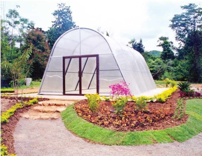
รูปที่ 9 เครื่องอบแห้งที่ปรับปรุงแล้ว ซึ่งติดตั้งที่โครงการอุทยานธรรมชาติวิทยาฯ อำเภอสวนผึ้ง จังหวัดราชบุรี
